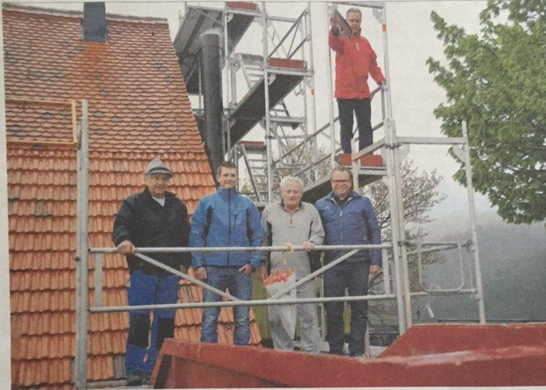
Alfred Böni, Präsident der Genossenschaft Rossberg, wirft den Dachziegel über (v. l.) Dachdecker Toni Höfliger, Zimmermann Roland Hitz, Bauchef Hansruedi Föllmi und Architekt Roland Hüppi in die bereitstehende Mulde.
